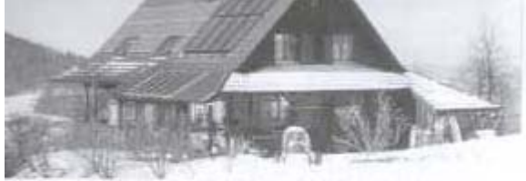
Şekil 19. Topaçların ve güneş pillerinin çatı ile birlikte çözüldüğü bir örnek (8).
