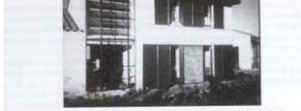
Şekil 9. Fransa – Perpignan'da pencereleri ve Trombe duvarları kayar kapı ile korummuş bir ev (Fotoğraf: Nur Demirelek)
